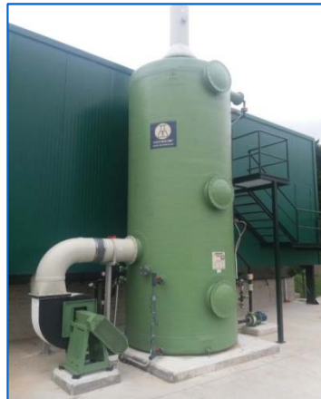
Desodorización en EDAR industrial con dos biotricklings en serie (Q = 30.000 m 3 /h, 100 ppm de H 2 S). Aporte de agua: efluente procedente del tratamiento secundario.
