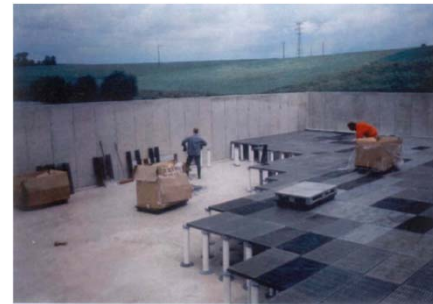
Detalle de colocación de las parrillas y los soportes
