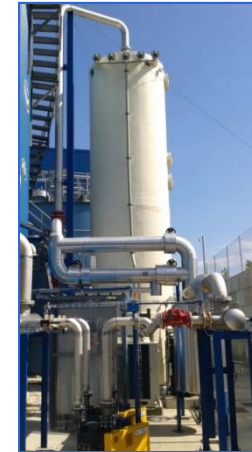
Desulfuración en EDAR urbana (Q = 600 m 3 /h, 3.500 ppm de H 2 S)
