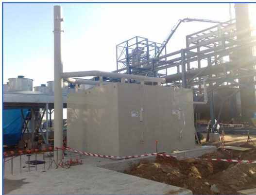
Desodorización en planta de purines (España) con biofiltro orgánico modular para Q = 2 \times 1750 \text{ m}^3/\text{h}
