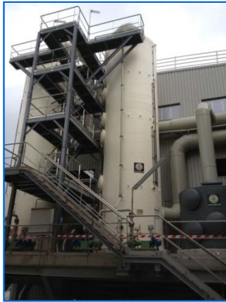
Desodorización en EDAR industrial con dos biotricklings en serie (Q = 30.000 m 3 /h, 100 ppm de H 2 S). Aporte de agua: efluente procedente del tratamiento secundario.
