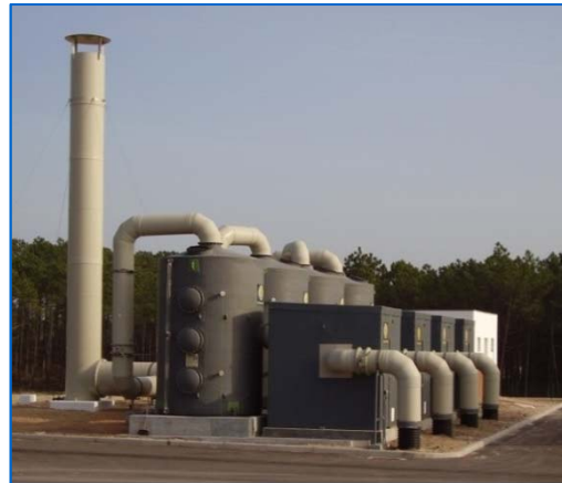
Desodorización en EDAR urbana con torre de doble lecho de carbón para 40.000 \text{ m}^3/\text{h}
