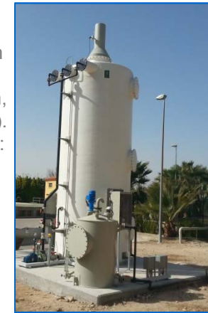
Desulfuración en EDAR urbana (Q = 600 m 3 /h, 3.500 ppm de H 2 S)
