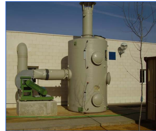
Desodorización en EDAR urbana con torre de doble lecho de carbón para 8.000 \text{ m}^3/\text{h}
