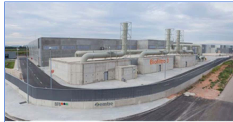
Desodorización en planta de compostaje (España) con etapa de prehumidificación y 1 Biofiltro inorgánico + 2 Biofiltros orgánicos para Q = 550.000 \text{ m}^3/\text{h}
